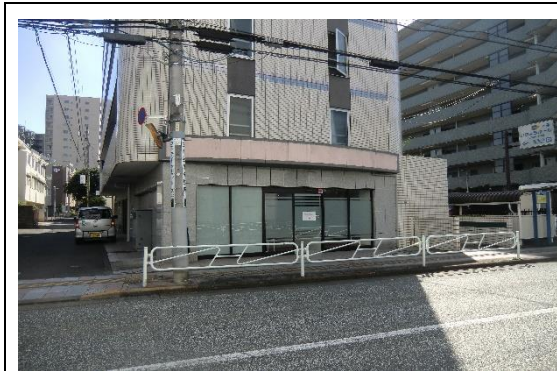
リエイブルメントティセンター(本町)
